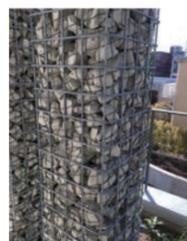
《ジャコゴ楯》金網状の雨樋に入った軽石が排水遅延と蒸散冷却効果をもたらす
