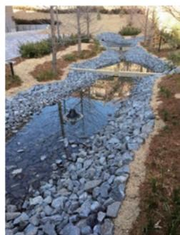
雨水や地下からの湧水の流水を抑制するレインガーデン
